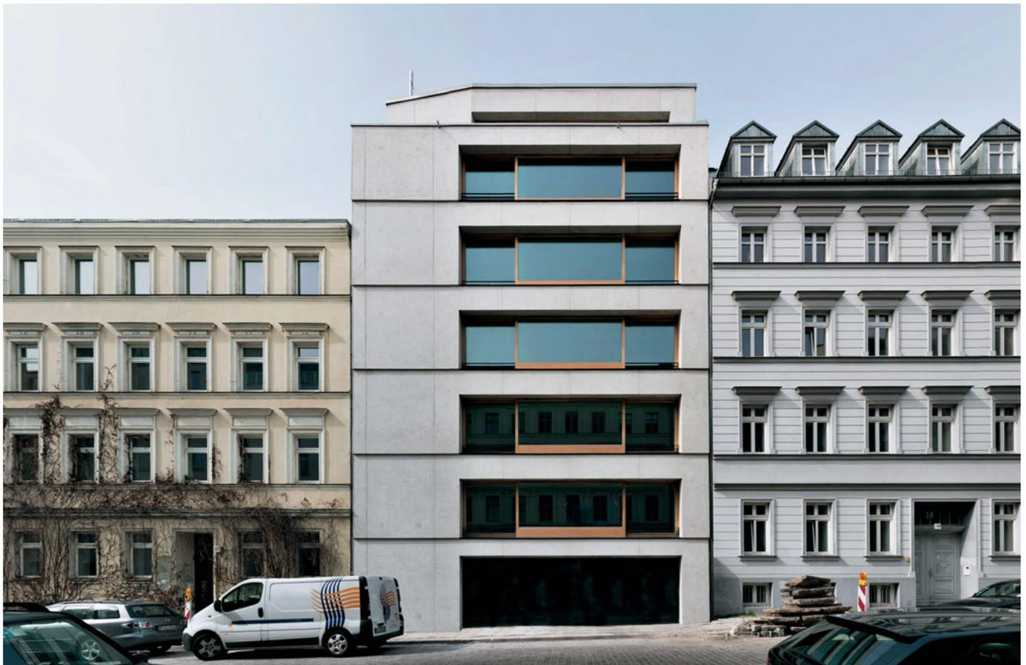
Für die Außenwände und Brandwände des siebengeschossigen Wohnhauses kam Dämmbeton mit einer Rohdichte von  $1,4 \text{ kg/m}^3$  zum Einsatz, dem Flugasche, leichter Vulkansand und Blähton beige-mischt sind. Probewürfel der gewählten Rezeptur ergaben eine Wärmeleitfähigkeit von  $0,38 \text{ W/mK}$ . Damit erreichen die Außenwände bei einer Mindestwandstärke von  $55 \text{ cm}$  einen U-Wert von  $0,618 \text{ W/m}^2\text{K}$ .
